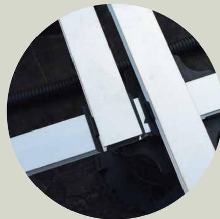
Terrasse wurden 300 Stelzlagern Balance Pro und 80 laufende Meter Balken Mini Rail verwendet. Dieselben Balken wurden auch zur Realisierung der vertikalen Wände der Terrasse verwendet. Als Finish wurde ein natürliches Teakholz mit Nutverbindung an den Köpfen verwendet, so dass sie auch ohne Balken montiert werden können.
